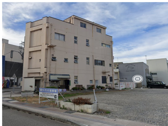
解体前の建物
