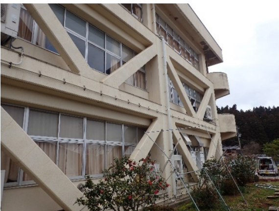
外付け補強ブレース
