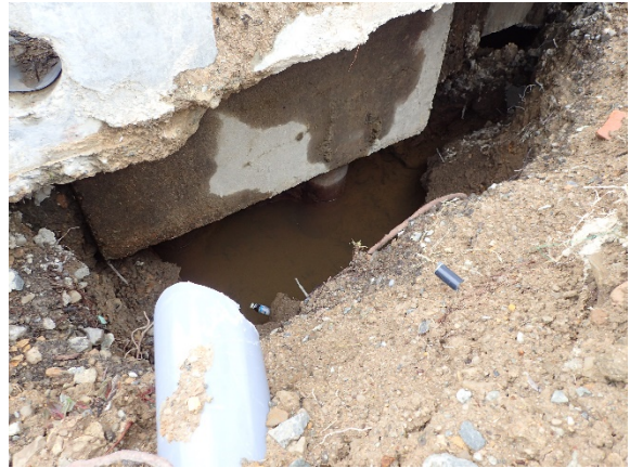
基礎下の杭頭部（損傷は見られなかった）
