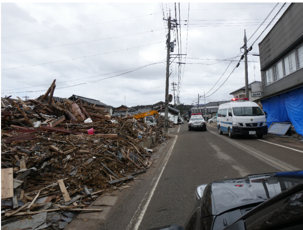
強震観測点周辺の木造住戸倒壊
