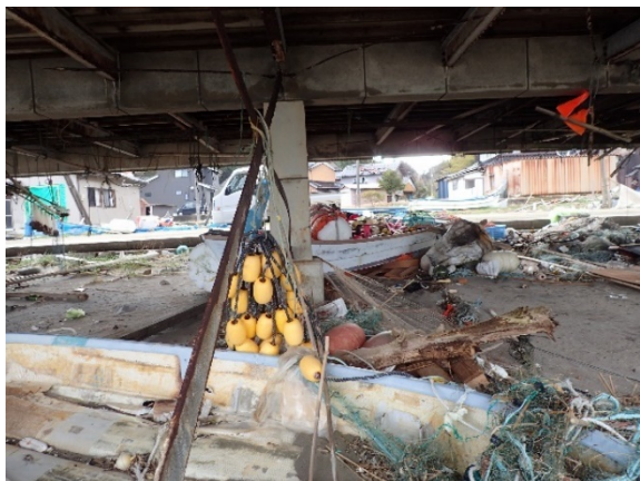
圧縮側ブレースの座屈
