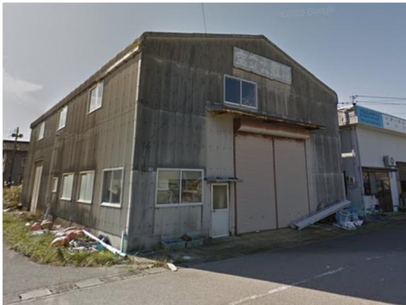
地震前の倉庫（Google Street View）
