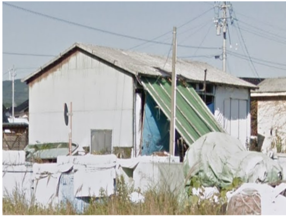
地震前の倉庫 (Google Street View)
