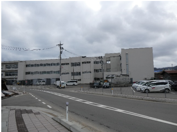
学校全体写真（右端が傾斜建物）
