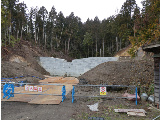
建設途中の砂防ダム
