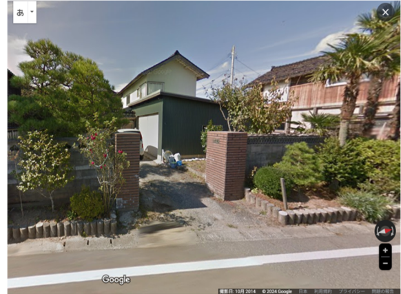
津波被災前の様子 (Google Street View)
