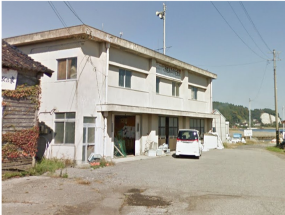
地震前の建物 (Google Street View)
