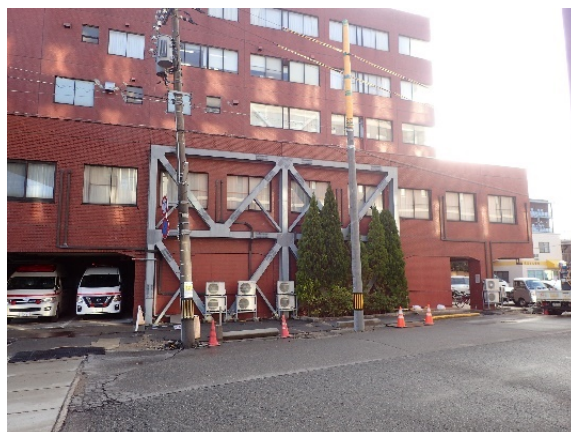
耐震補強した棟
