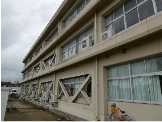
耐震補強した校舎
