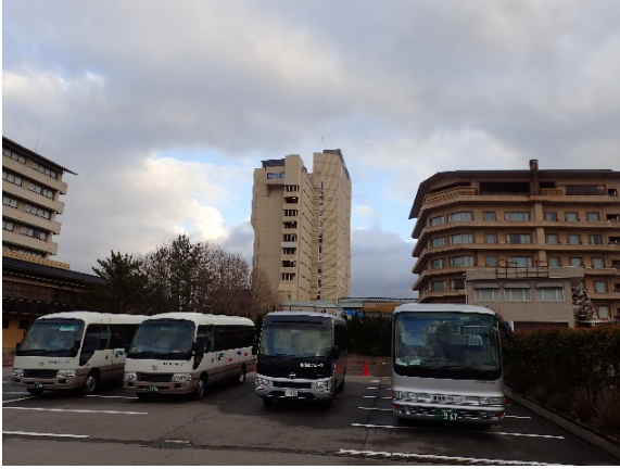
建物全体写真
