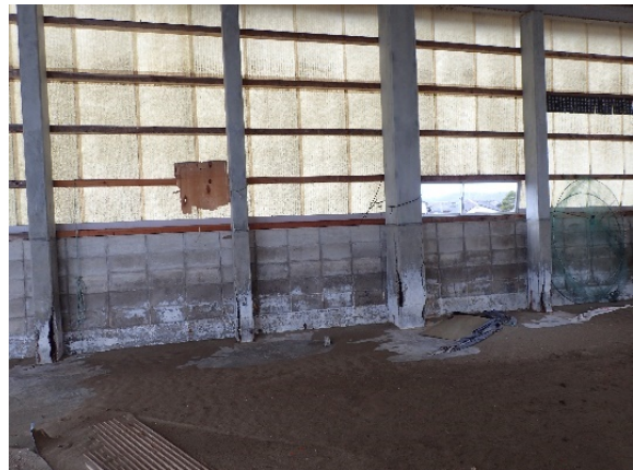
残置していた 5 段積のコンクリートブロック塀
