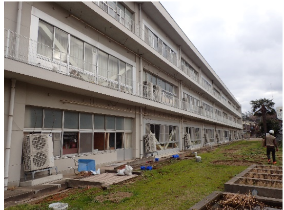
耐震補強された校舎
