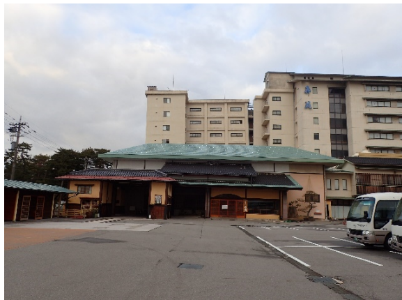
傾斜した建物の全景
