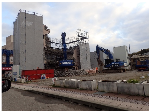
解体中の建物
