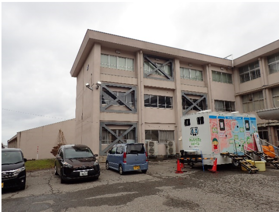
鉄骨ブレースによる耐震補強
