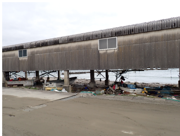
道路側からの全景
