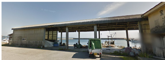
地震前の倉庫（Google Street View）
