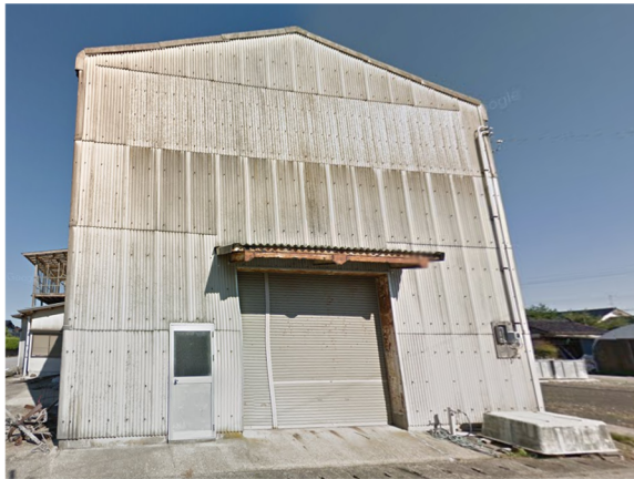
地震前の倉庫 (Google Street View)
