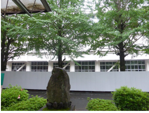
耐震補強された体育館
