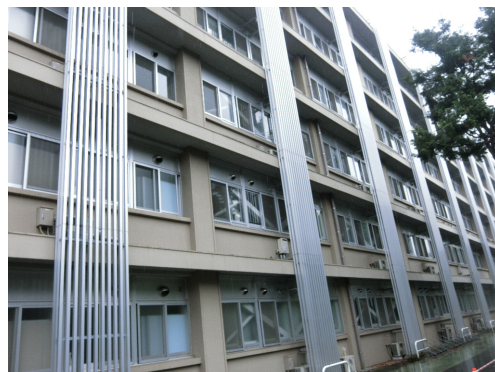
校舎外観（校舎2）
