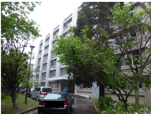
校舎外観（校舎1）
