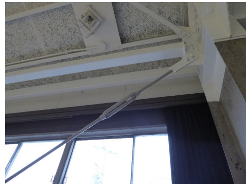
既存の水平ブレース
