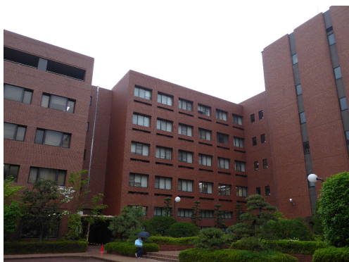
校舎外観（校舎1）
