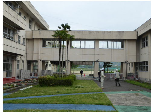
渡り廊下外観
