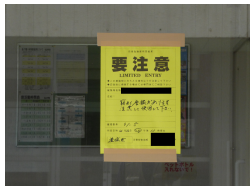
応急危険度判定(体育館)
