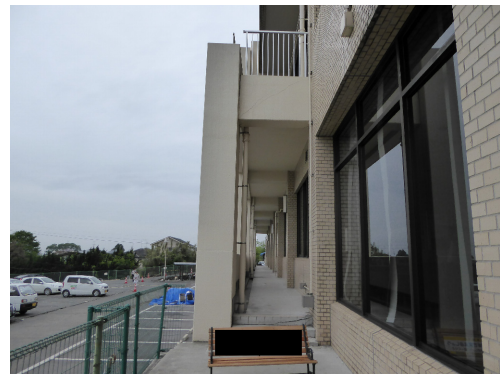
外付けフレームのせん断ひび割れ
