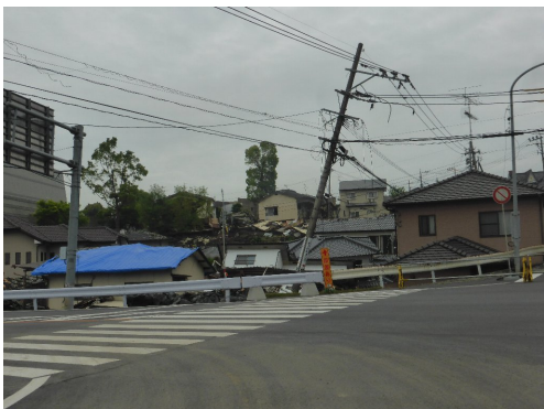
益城町 電柱の傾斜
