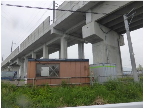
宇土市 RC造橋脚 (無被害)
