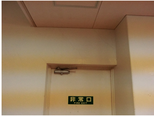
短スパン梁のひび割れ
