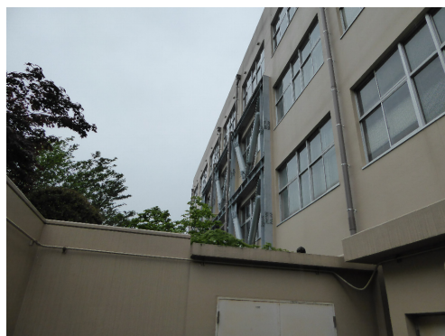
校舎外観（校舎2）
