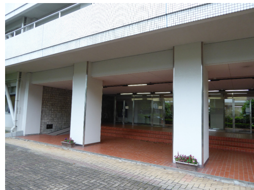
繊維補強シートによる補強
