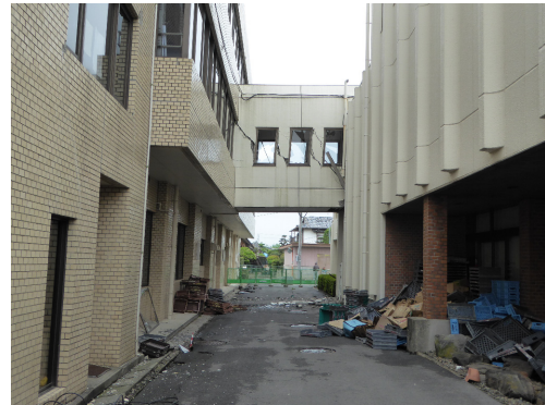
渡り廊下外観
