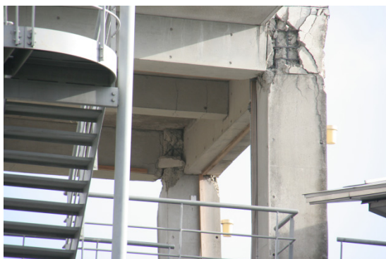
4階柱梁接合部（南側より望む）
