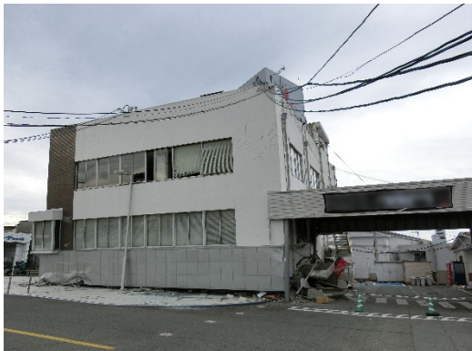
建築物南側外観
