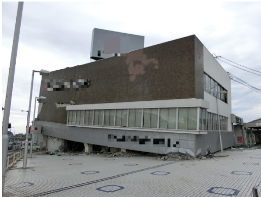
建築物西側外観
