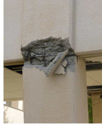
渡り廊下1階柱頭
