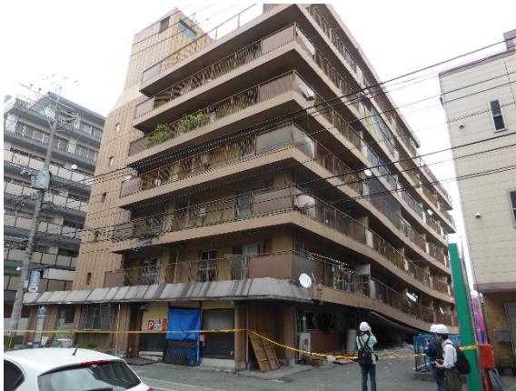
建物南構面外観
