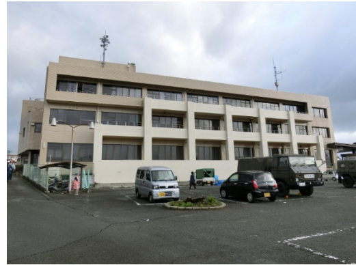
南側外観 (外付けフレーム補強)
