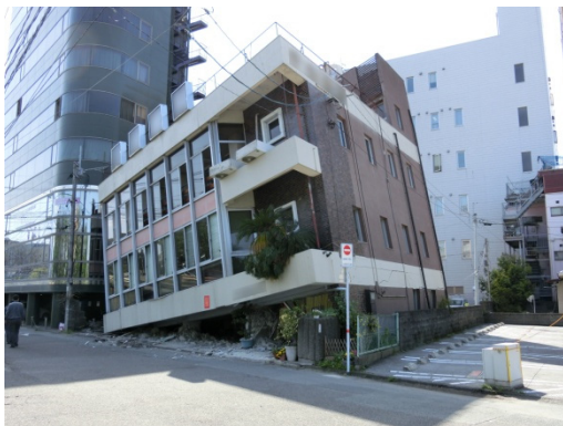
建築物北面・東面外観
