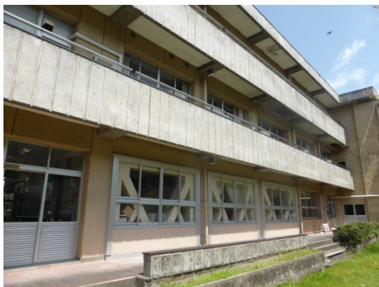
鉄骨ブレースによる耐震補強
