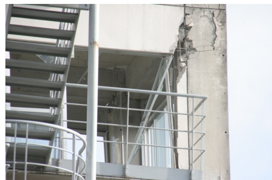
5階柱梁接合部（南側より望む）
