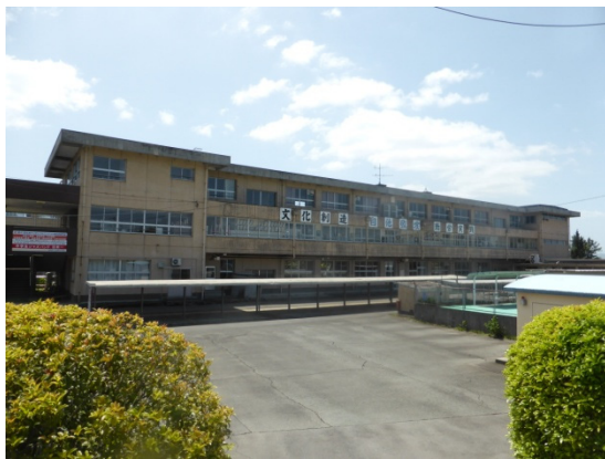
北側校舎全景
