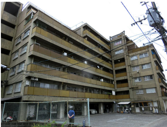
建物南構面外観
