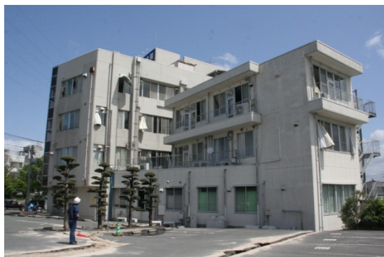
建物外観（南西）
