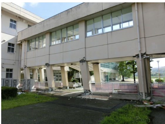
渡り廊下東棟の外観
