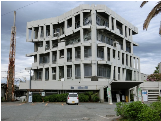
建築物南西側外観
