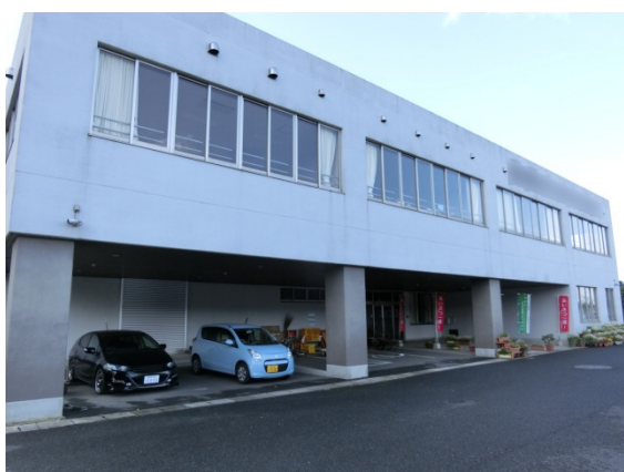
本校舎 南構面外観
