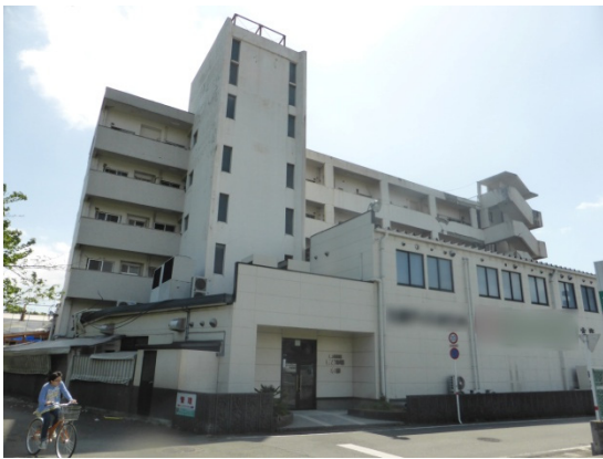
建物南側外観
