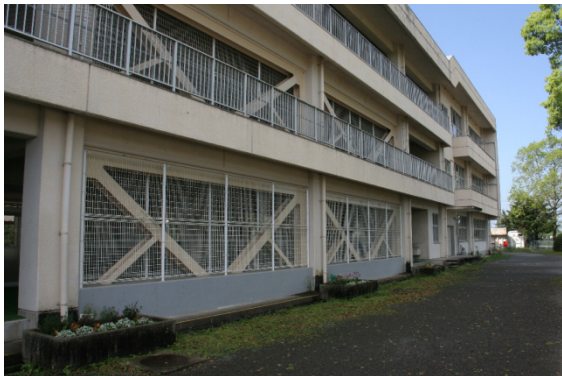
北側校舎外観
