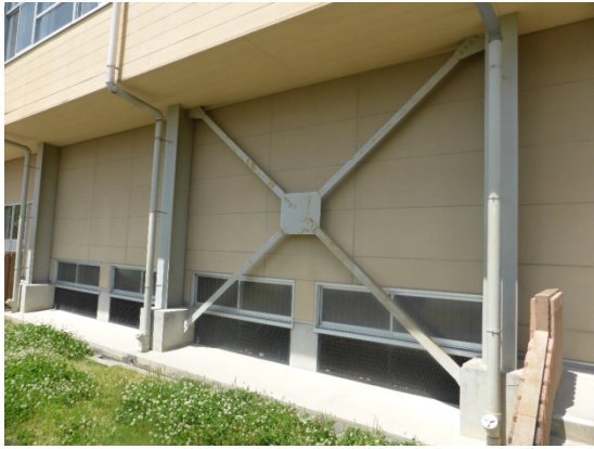
体育館 1 階のブレース
