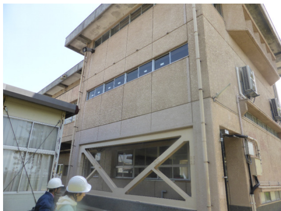
鉄骨ブレースによる耐震補強
